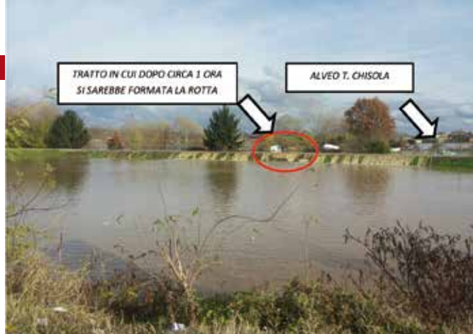
Foto 1 - Torrente Chisola a Moncalieri – Argine sinistro a monte del ponte di Strada Barauda 25/11/2016 ore 14.00
