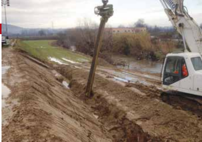
Foto 6 - Chiusura breccia di valle: infissione delle palancole a lato fiume
