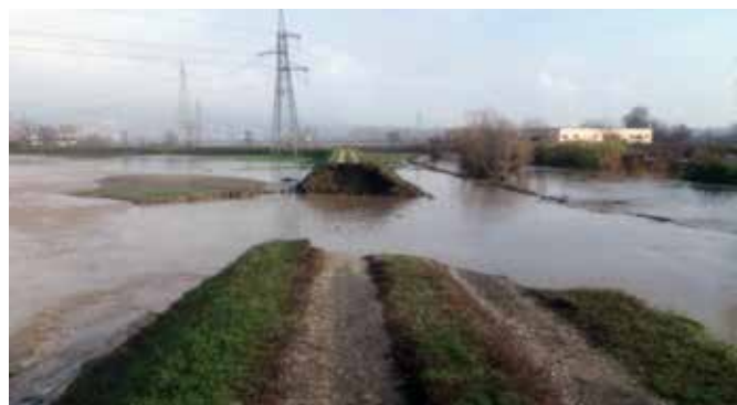
Foto 3 - Rotta arginale a valle del ponte di strada Barauda su argine sinistro - Vista da monte verso valle - 26/11/2016
