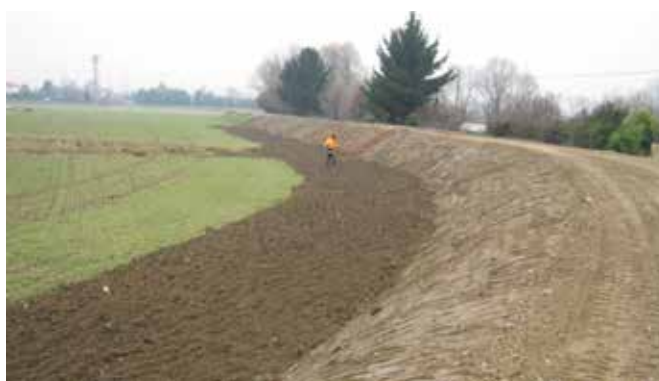
Foto 5 - Chiusura breccia di monte: conclusione dei lavori complessivi di ripristino
