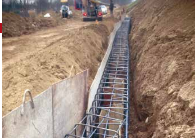
Foto 7 - Chiusura breccia di valle: armatura del cordolo in testa alle palancole
