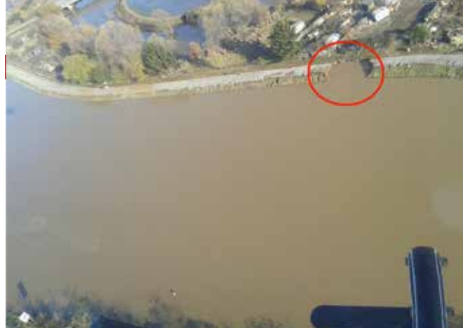
Foto 2 - Particolare della breccia formatasi nel corso dell'evento a monte del Ponte di strada Barauda Vista aerea 26/11/2016.
